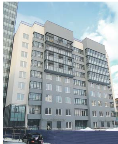
На Лесном пр., 67 к началу нового семестра будет сдан в эксплуатацию 10-этажный корпус общежития квартирного типа. Сейчас ведется внутренняя отделка помещений
