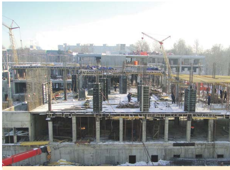
В рамках выполнения Федеральной целевой программы ведется строительство Научно-исследовательского корпуса ОНТИ
