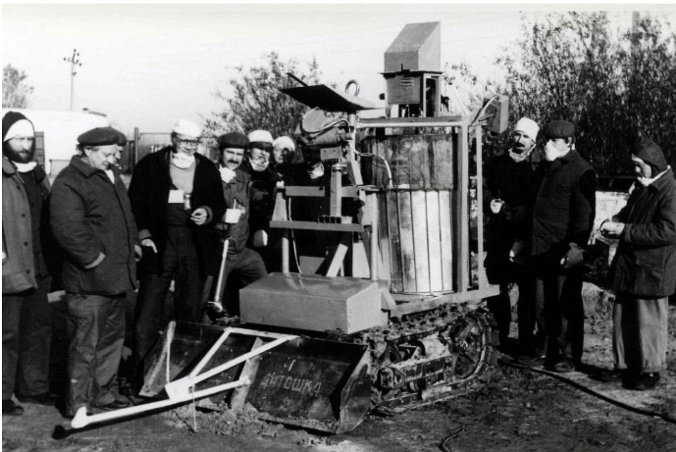
Всего ЦНИИ РТК для Чернобыля было создано около 15 специальных роботов. С их помощью с июня 1986-го по апрель 1987 года было обследовано более 15 000 квадратных метров помещений внутри станции, кровли зданий и территории ЧАЭС, очищено 4 000 квадратных метров кровли зданий станции со сбросом радиоактивного мусора с частей взорвавшегося энергоблока № 4 в провал, образовавшийся на его месте, очищено 600 квадратных метров особенно сильно загрязненной территории так называемых «иловых полей».
