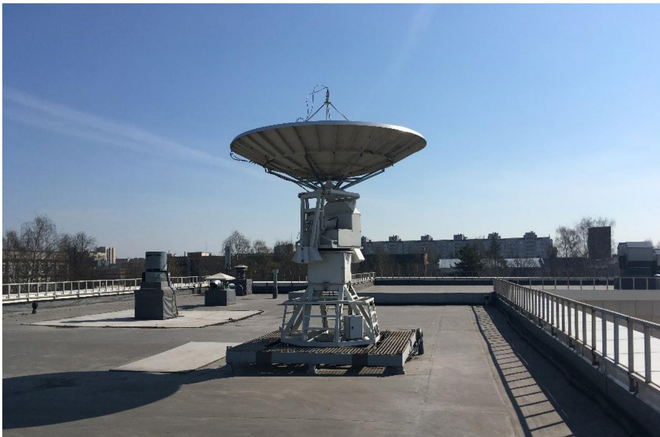
В период с 8 часов 35 минут до 9 часов был проведен сеанс по приему информации с низкоорбитального спутника «Аист-2Д». Базой для проведения эксперимента стал Научно-исследовательский корпус СПбПУ, на крыше которого установлена приемная станция. Ее управление в автоматическом режиме осуществляется из научной лаборатории «Космические телекоммуникационные системы» ИФНиТ.
