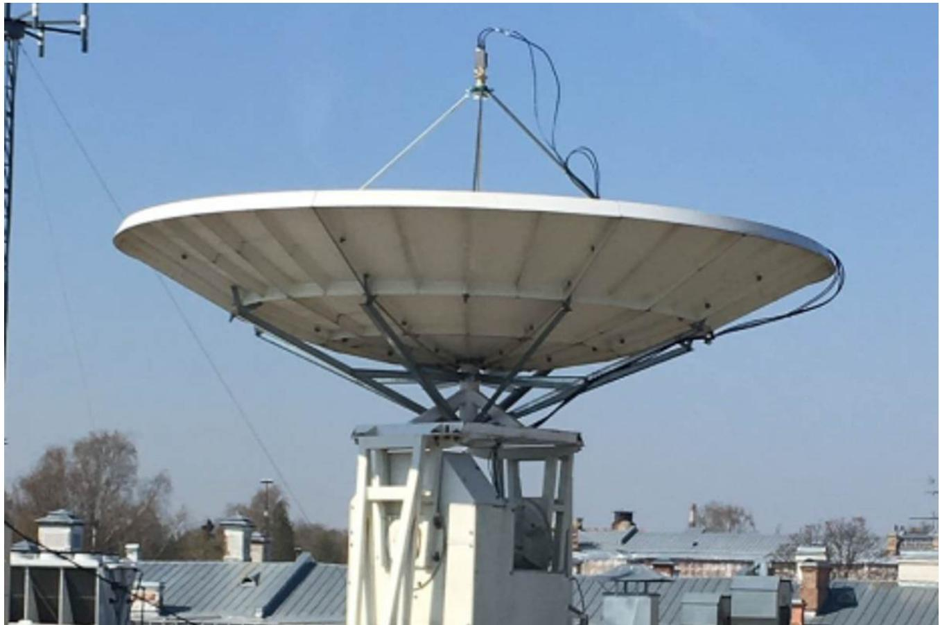
На сегодняшний день закончена разработка АИС и начата подготовка к сборке двух микроспутников. На крыше СПбПУ расположено антенно-мачтовое устройство «Радиан 3.6» для приема сигналов АИС в диапазонах частот S, C и X наземной станции приема и обработки спутниковой информации, размещенное на крыше НИК СПбПУ. Антеннное устройство обеспечивает работу в составе целевых радиолиний всех доступных и перспективных отечественных микроспутниковых платформ.
