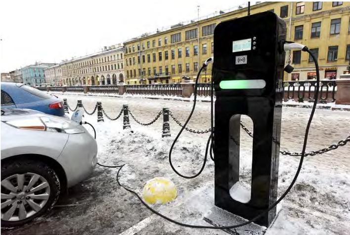
«Установленная зарядная станция переменного тока имеет совокупную максимальную мощность 44 кВт и может одновременно заряжать два электромобилей, – объяснил генеральный директор компании «Зарядные станции «Яблочков», выпускник СПбПУ Алексей МОТОРЕНКО. – Станция полностью изготовлена компанией в Санкт-Петербурге: это наша разработка, наши контроллер, силовые агрегаты, управляющее программное обеспечение».
